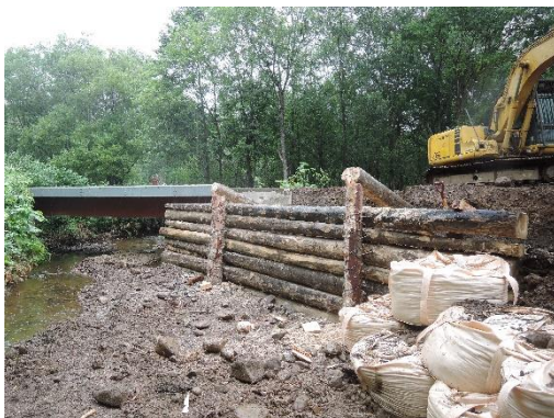
▲「宇津内地区橋台丸太護岸工」 現地発生材を使った護岸工事
