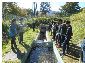
施設内の魚道(人工河川)
