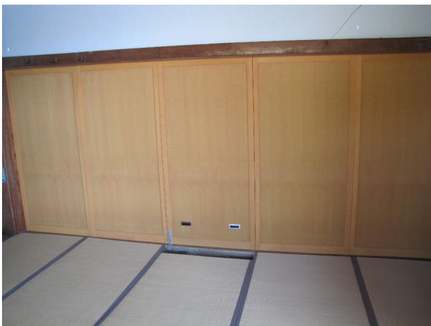
写真3 2階宿泊室の間仕切り
