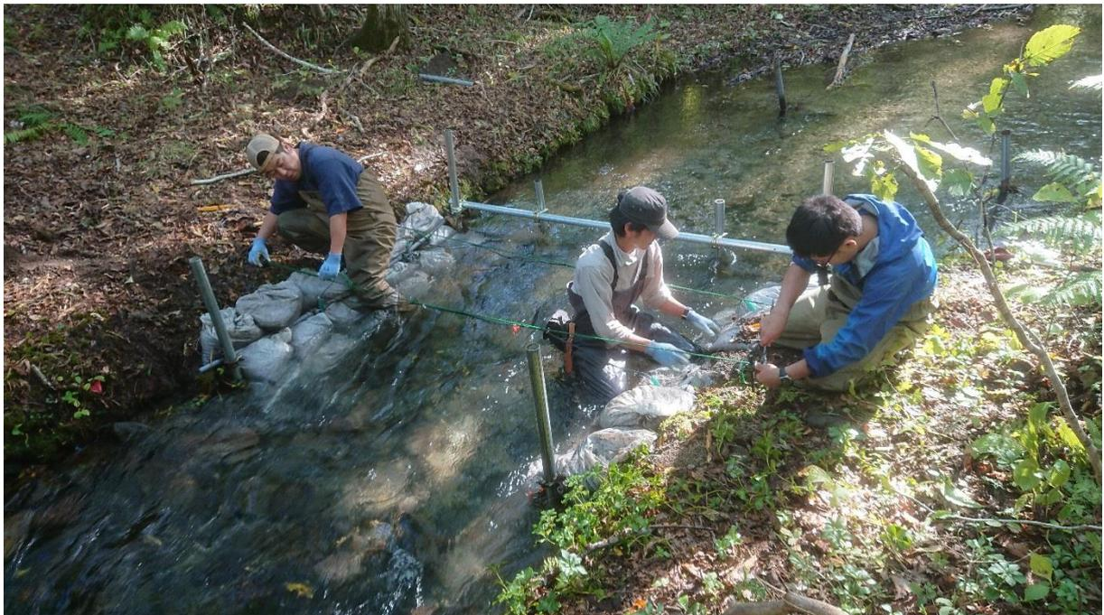
IC タグの読み取り装置の設置の様子
