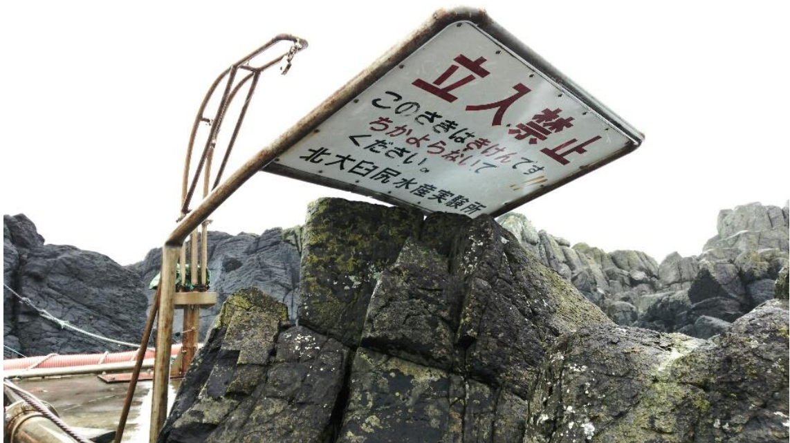
写真 3 波によって 90 度に折られた取水地の立て看板
