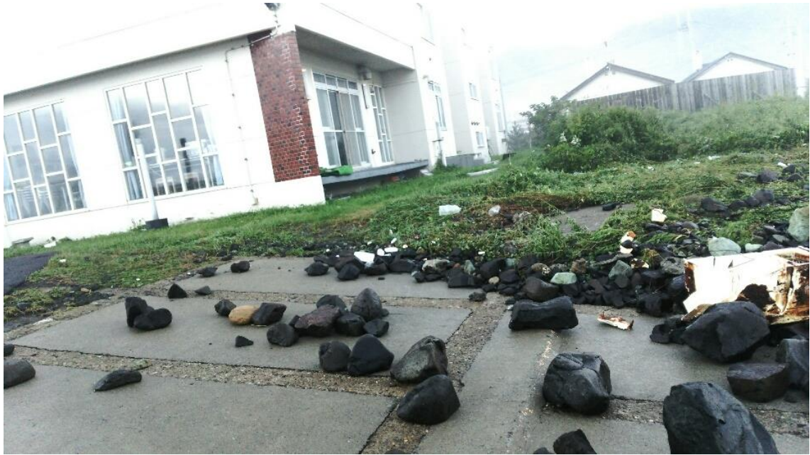
写真 2 波によって宿泊棟の裏庭まで大きな石が打ち上げら
