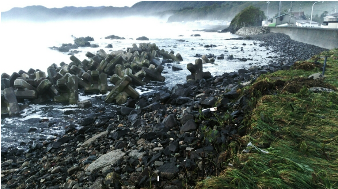
写真1 低気圧で吹っ飛んだテトラポット
