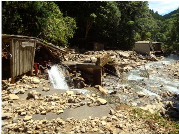
土石流で損壊・流出した倉庫。8月28日撮影
