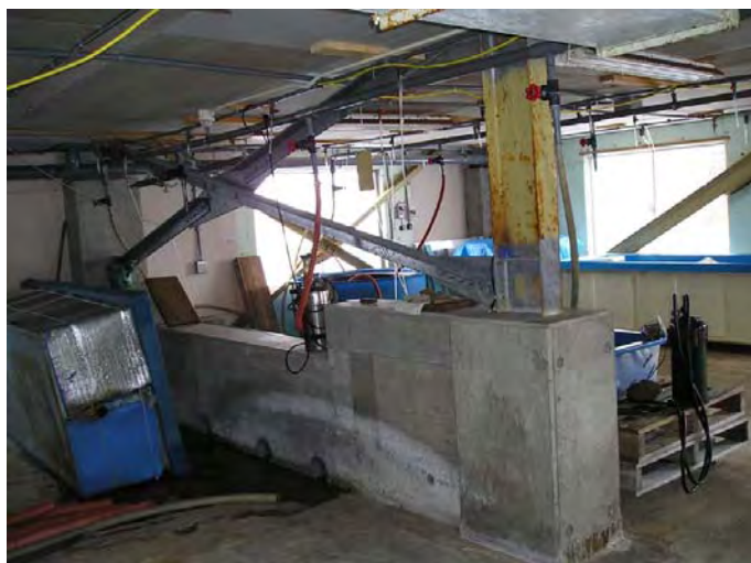
補強壁(新設)
