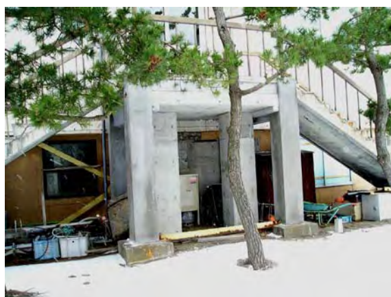
玄関下(工事後)
