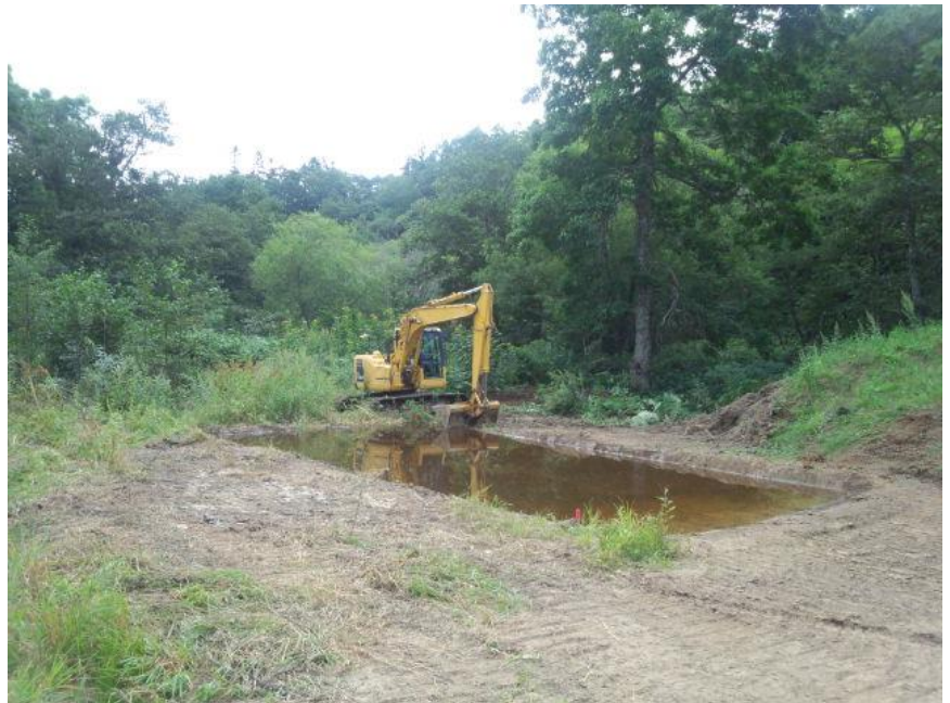
パワーショベルで実験池を掘削する様子（天塩研究林・五十嵐の沢）
