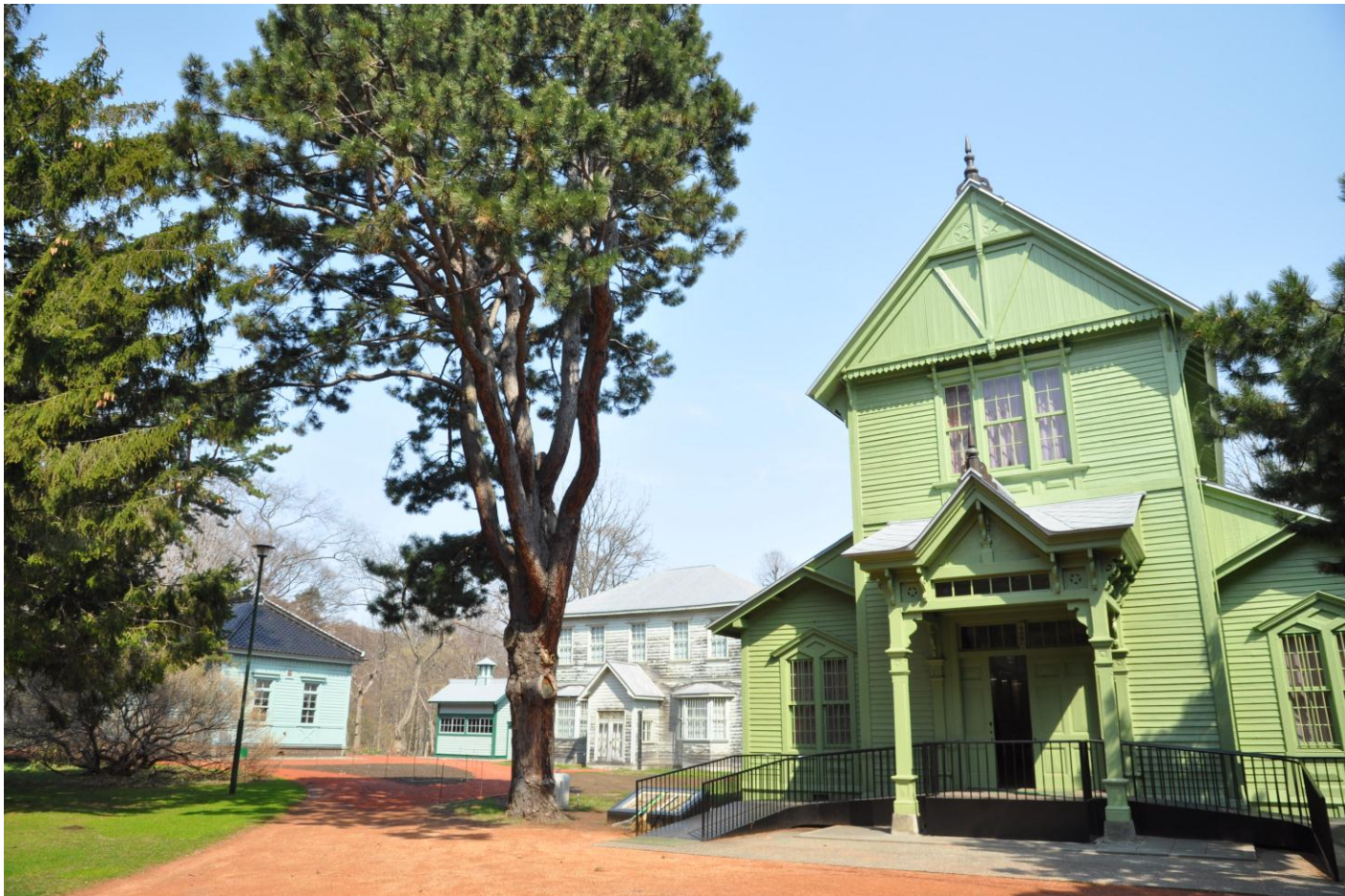
工事終了後の博物館本館
