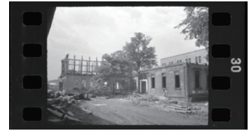
図版 279 N01612 1964年 札幌 農学部水産学科講堂取り壊しの様子
