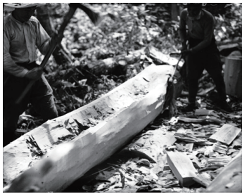
図版 085 N50078 1937年6月 雨竜 丸木舟の製作（荒削りの丸木舟）
