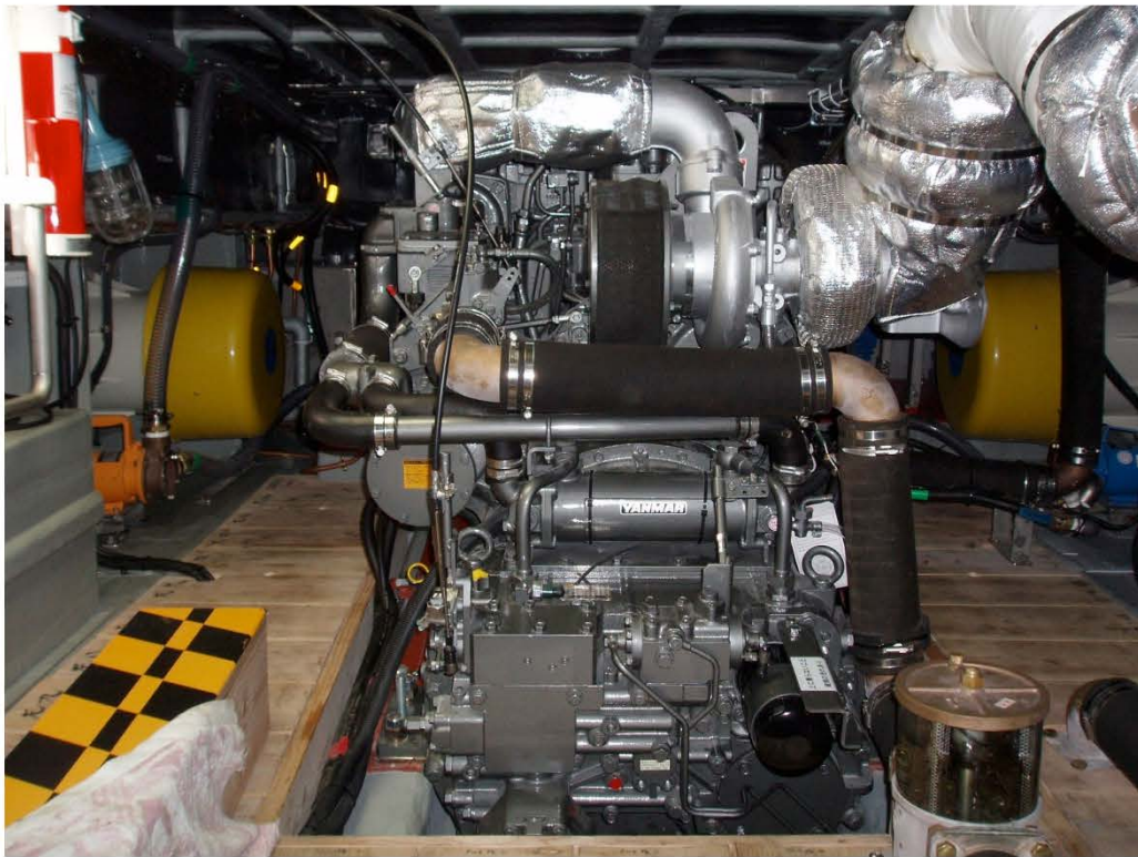
機関室 ヤンマー6KXZS-GT
